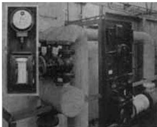
Abb. 7. Anlage zur Überwachung des Synthesengemisches auf Stickstoff in einer Stickstofffabrik.
